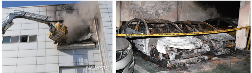
2018년 8월 인천시 S전자 공장 화재 - 피해규모: 근로자 9명 사망 - 화재원인: 소방펌프 작동 불능 상태로 방치
