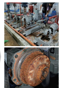
주물 제작 임펠러 부식 → 펌프 고착 (작동 불능) → 화재 시 스프링클러 미작동
